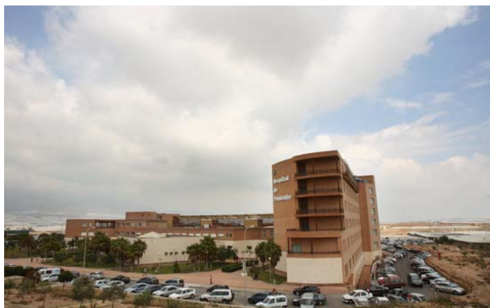
Estructura. Hospital de Poniente.
