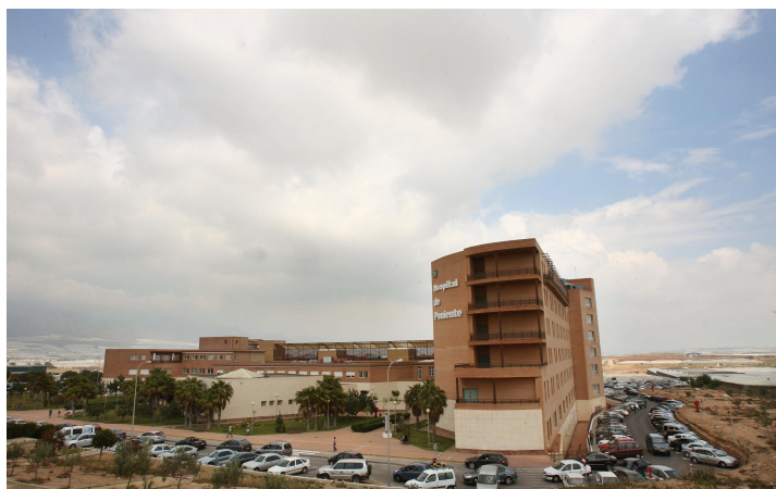
Estructura. Hospital de Poniente.
